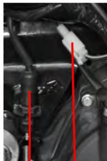
ΖΕΥΓΟΣ ΑΝΑΦΛΕΞΗΣ ΝΔ. ΣΤΟ ΚΥΡΙΟ ΚΑΛΩΔΙΟ ΣΥΝΔΕΣΗ ΚΥΡΙΟΥ ΚΑΛΩΔΙΟΥ ΣΤΟ ΜΕΤΡΟ
